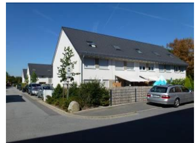
Reihenhausbebauung an der Körnerstraße
